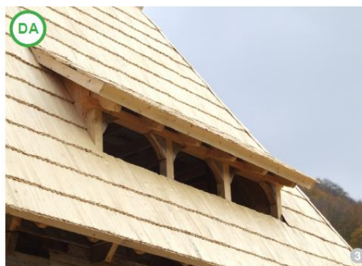
ASA DA: Micile lucarne într-o singură pantă, amenajate în mansarda unei clădiri secundare, pot aduce suficientă lumină pentru spații precum dormitoare, băi etc. Tipul de lucarnă cu o singură pantă aduce aminte de golurile de intrare în pod și pot avea dimensiuni consistente. Acest tip de lucarnă poate fi folosit și la casa principală, cu condiția ca dimensiunea lor să rămână între niște valori decente, mai mici decât la cele de la anexe, în funcție de gabaritul clădirii. În general, se recomandă ca acestea să se încadreze într-un dreptunghi de 60 x 80 cm pentru casele tradiționale.
