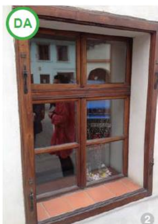
AȘA DA: Fereastră nouă cu două rânduri de geamuri, primul fiind multistrat
