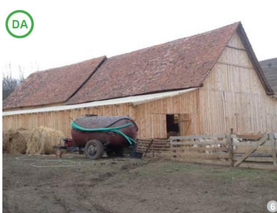
AȘA DA: La construcțiile zootehnice, se acceptă alternarea pantei acoperișurilor, cu condiția ca volumetria de ansamblu să se încadreze în specificul local, cum este cazul acestui adăpost pentru animale.
