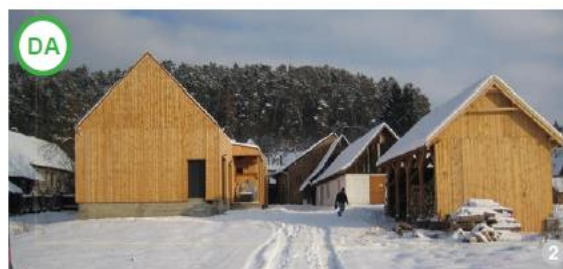
ASA DA: Acoperișul respectă panta minimă de 45 ° a construcțiilor din vatra satului.
