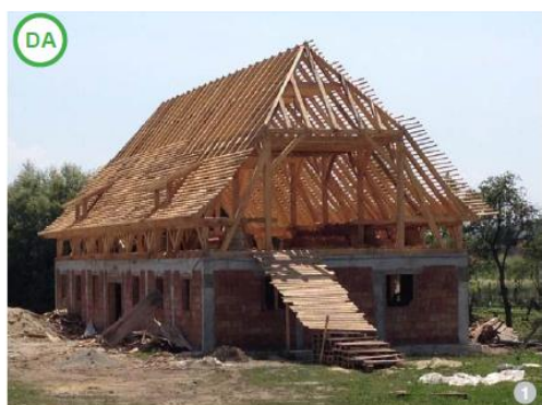
ASA DA: Acoperișul se inspiră din soluțiile tradiționale locale folosite la clădiri cu gabarite mari – proiect realizat cu finanțare europeană.
