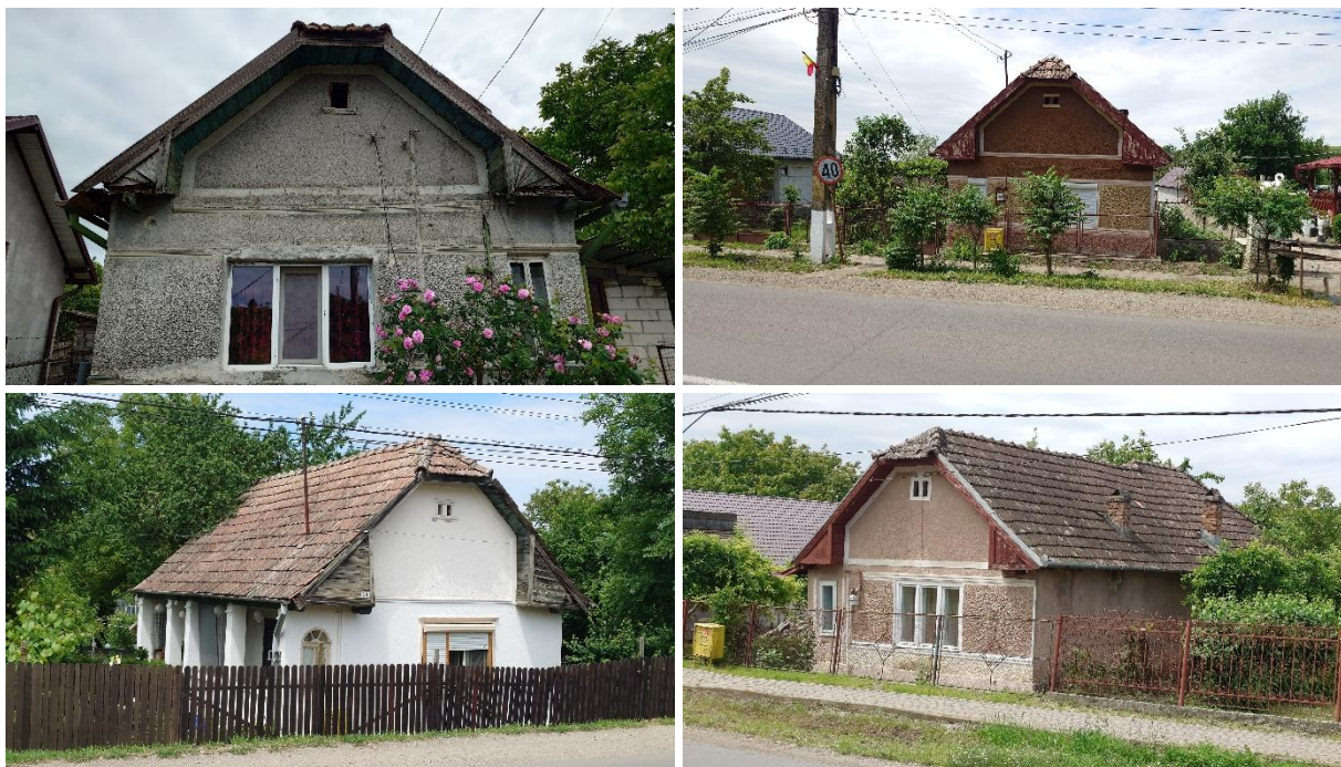
Figura 40 – Frontoane cu ancadrament de lemn, în comuna Zau de Câmpie
