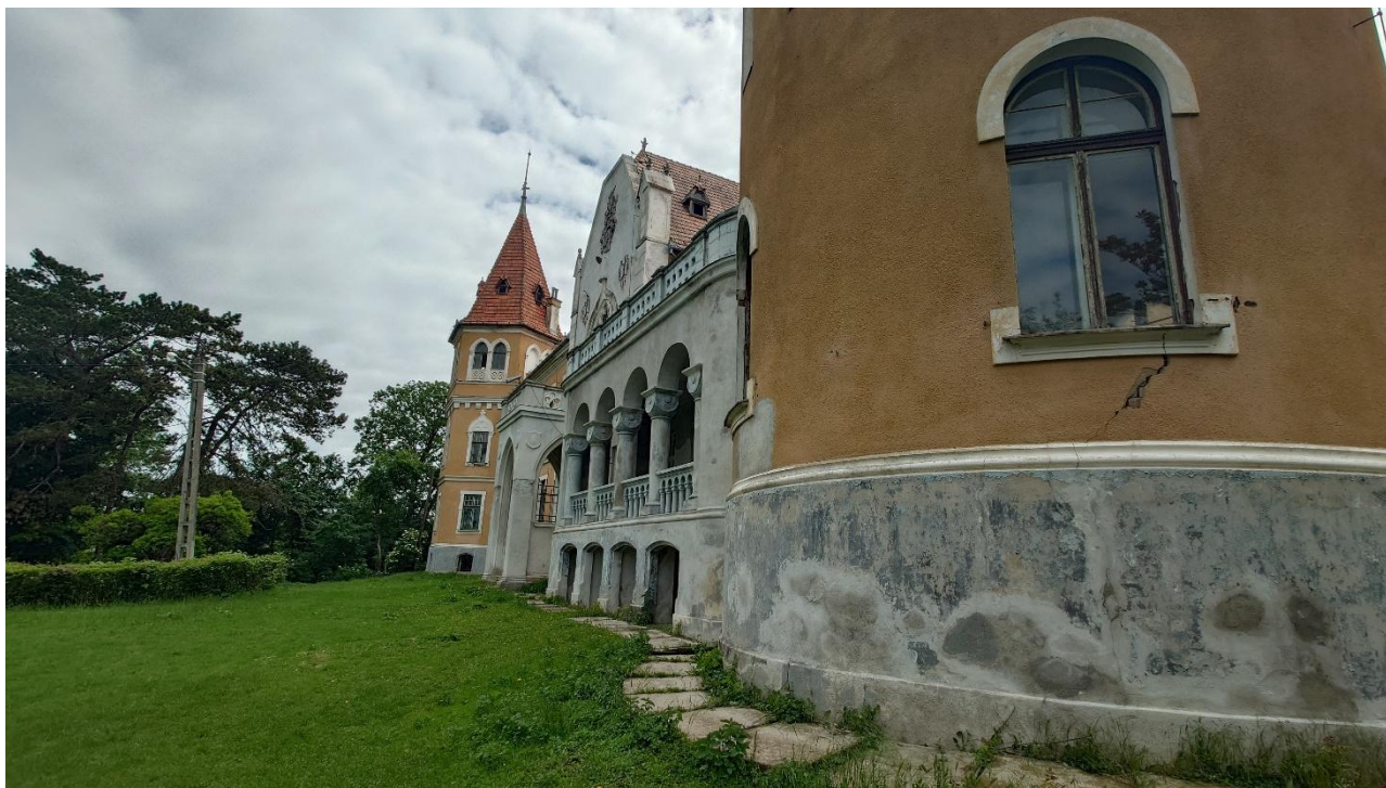
Figura 50 – Castelul Ugron, sat Zau de Câmpie, arhitectura exterioară III
