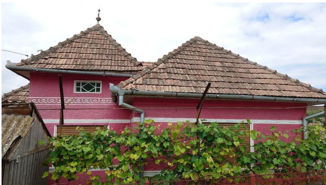
Figura 73 – Profil tipic de casă, cu brâu ornamentat și cortină vegetală, în satul Zau de Câmpie
