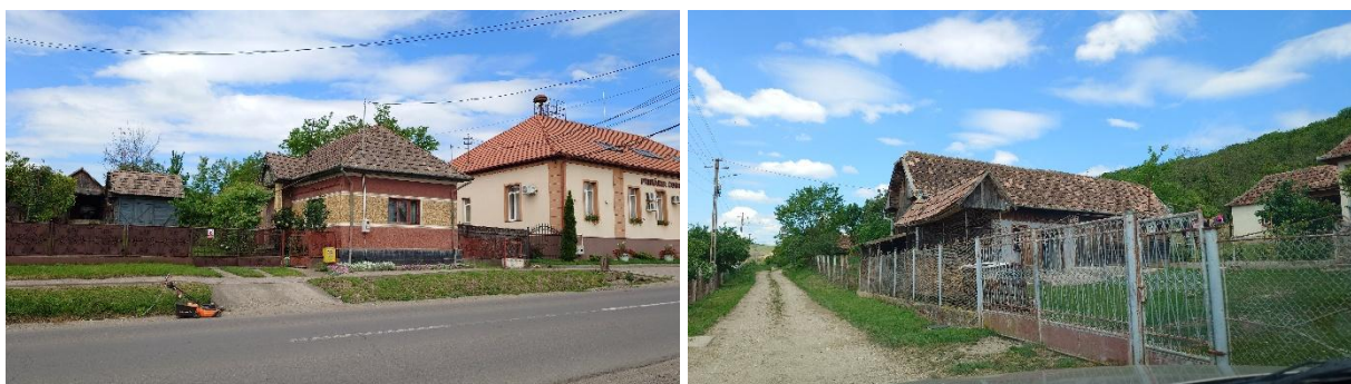
Figura 39 – Frontoane de lemn pe clădiri, în Zau de Câmpie
