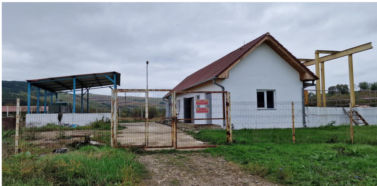
Figura 4 – Stația de epurare a comunei Zau de Câmpie
