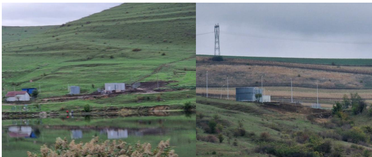
Figura 2 – Stația de tratare + captare (foto st.) + rezervor (foto dr.) - comuna Zau de Câmpie
